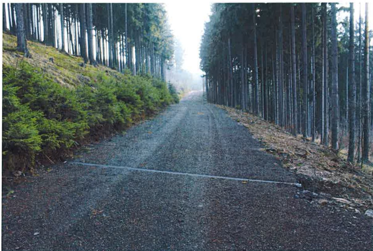
Nově zbudovaný úsek mostecké cesty
