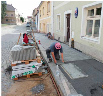
Oprava chodníků na Velkém náměstí
