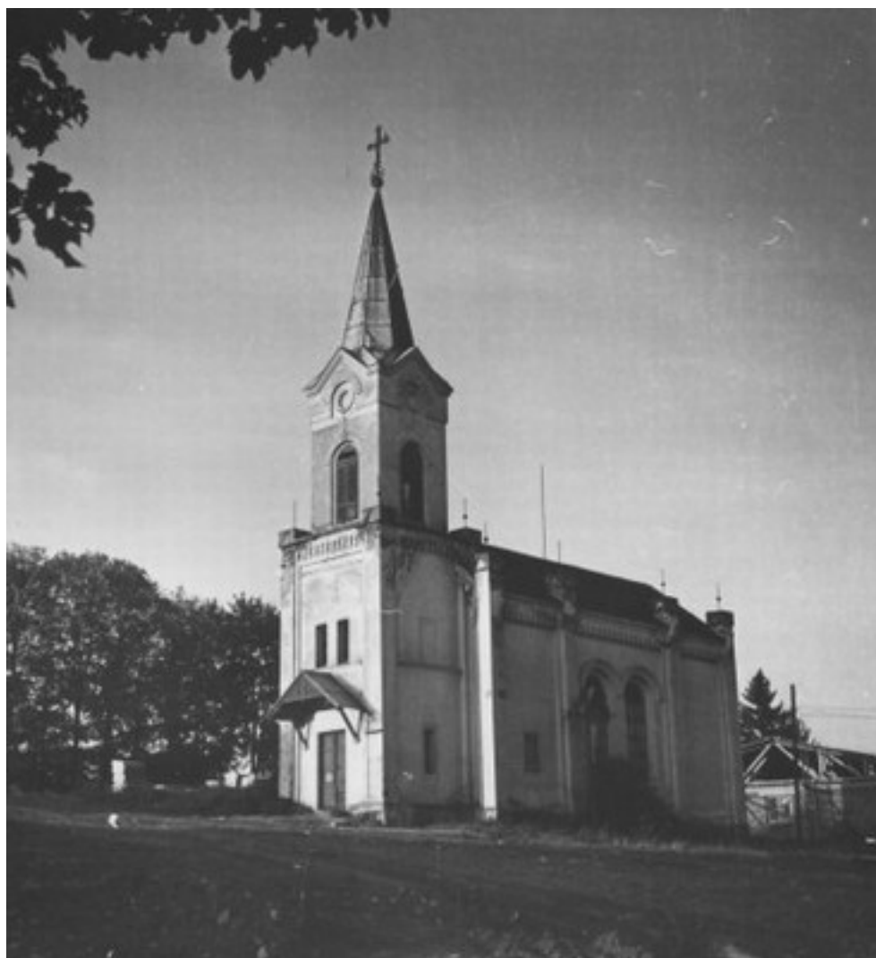
Hřbitovní kostel Nejsvětější Trojice před demolicí, rok 1964.
