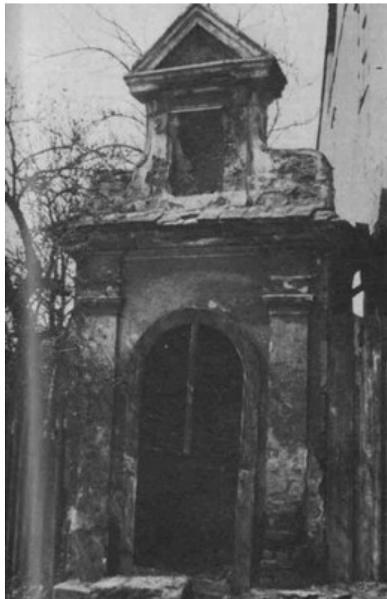
Kaple sv. Antonína Paduánského před demolicí, 2. pol. 20. stol.
