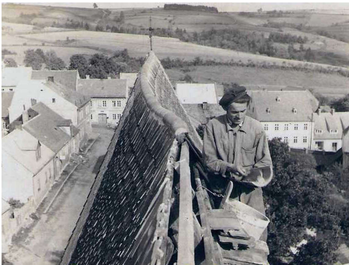
Pohled z farního kostela na zástavbu ulic Hradební a 28. října, 50. léta.
