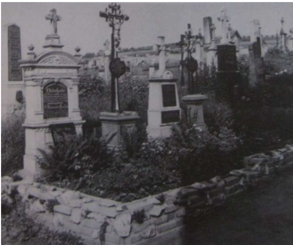
Hřbitov u kostela Nejsvětější Trojice na Hladově zničený v roce 1954, stav v roce 1938.
