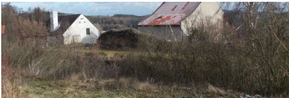
Opevnění severního okraje města se střepem hlavní hradební zdi, torzem parkánové zdi a zděného příkopu se zbytky valu.
