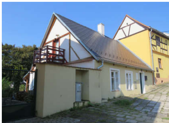
Obr. 4/ Dům č. p. 89, stav k r. 2020
