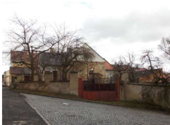
Pilířový omítaný plot, původně s dřevěnými výplněmi.
