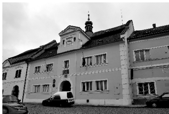
Obr. 2/ Stav před rekonstrukcí v r. 2012.
