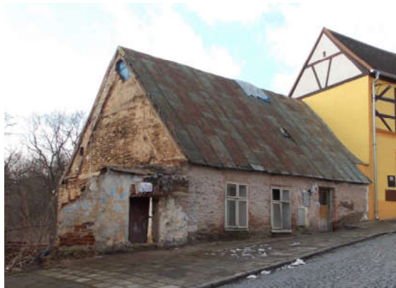
Obr. 5/ Dům č. p. 89, stav k r. 2013
