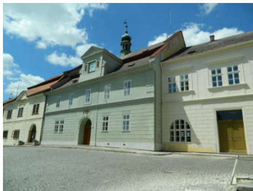
Obr. 1/ Stav po rekonstrukci v r. 2018
