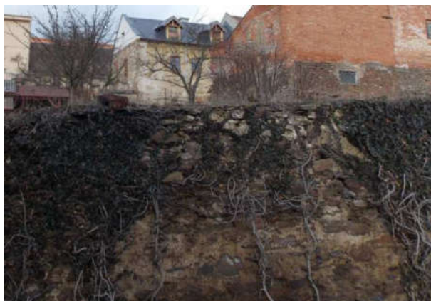
Zídka se zbytkem původního zadrnování koruny zdiva.
