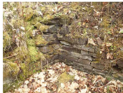
Fragment zdiva vnitřního nároží budovy v hradním jádře
